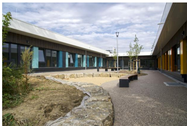
Ein Beispiel eines Innenhofes
